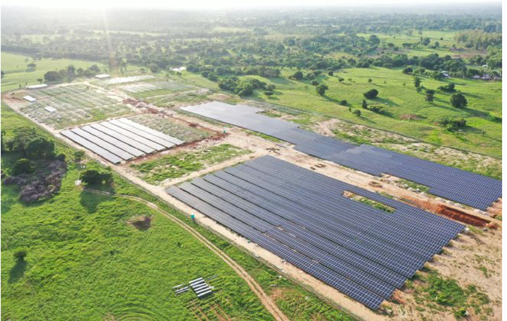
Pétalo de córdoba es un parque solar en Planeta Rica, Córdoba construido por GreenYellow para uso industrial. // Cortesía GreenYellow
