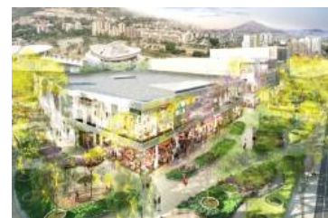
En video: así será Mallplaza, el nuevo centro comercial que se construirá en el sur de Cali
