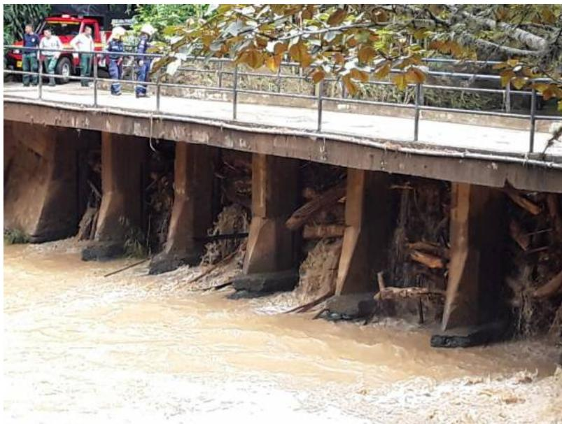
"Ese es un puente que tiene los cimientos muy cerca, entonces impide el libre paso del agua; sin embargo, hasta ahora no genera preocupación de un posible represamiento, porque el agua tiene por donde fluir. Con los Bomberos ya estamos trabajando para remover los objetos", agregó el funcionario.
