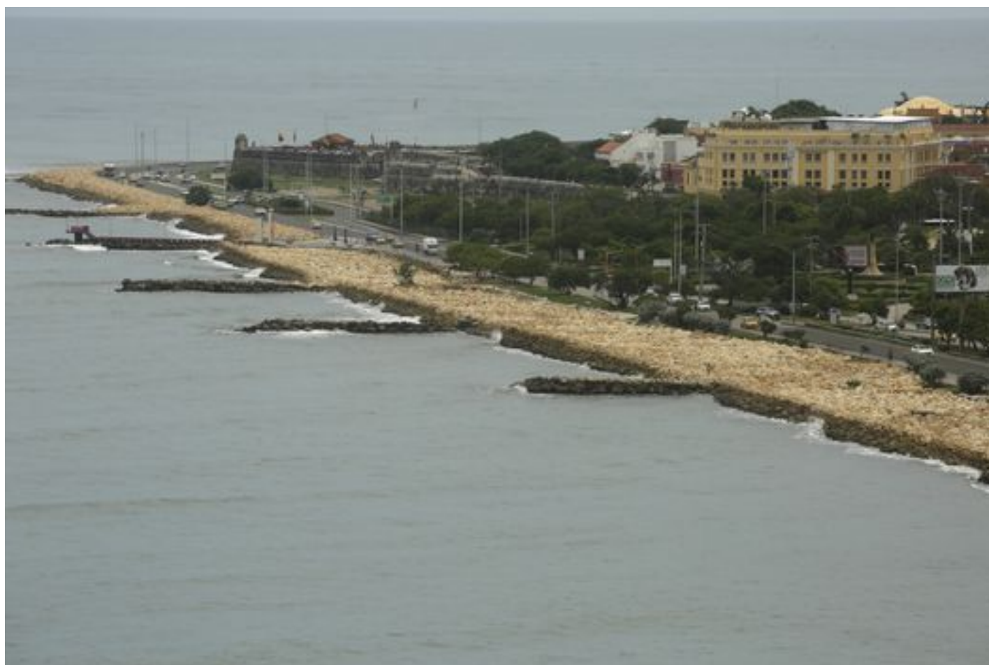
CTG001. CARTAGENA (COLOMBIA), 03/08/2022.- Fotografía de las obras de la protección
