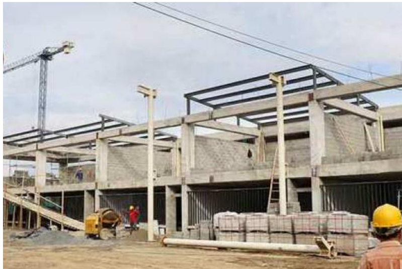
Este es uno de los colegios que avanza en su construcción en Cali.
