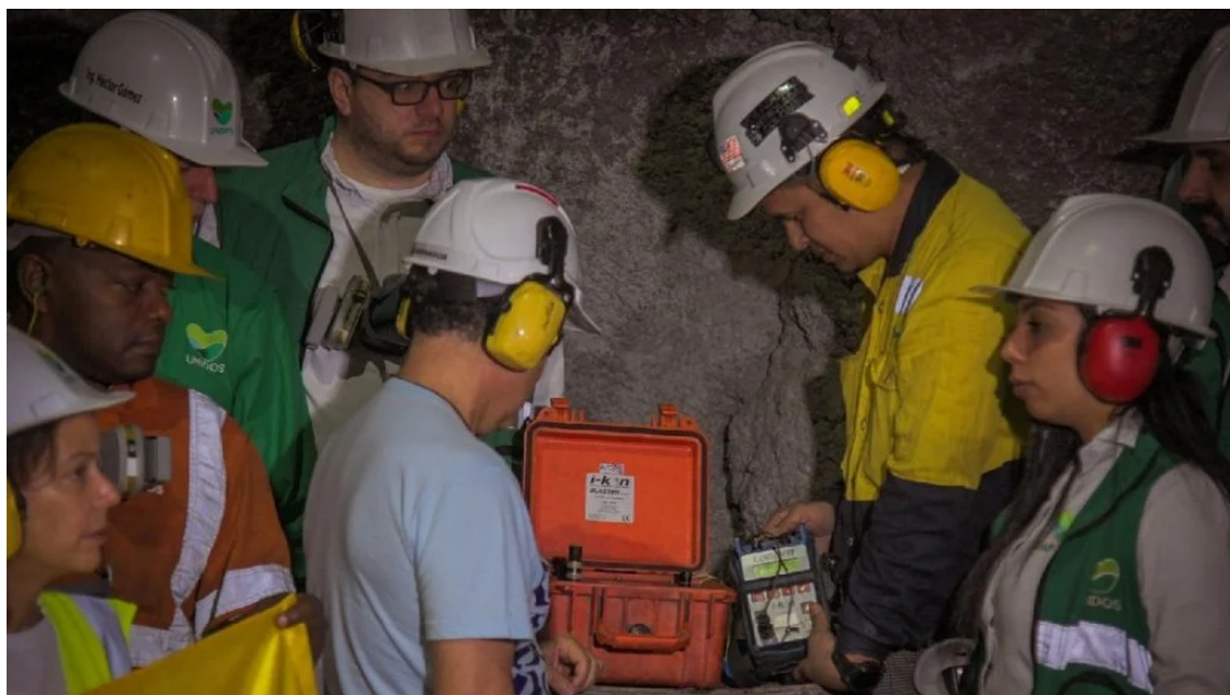
El megaproyecto del Túnel Guillermo Gaviria Echeverri operará a partir de 2025. Foto: Cortesía
