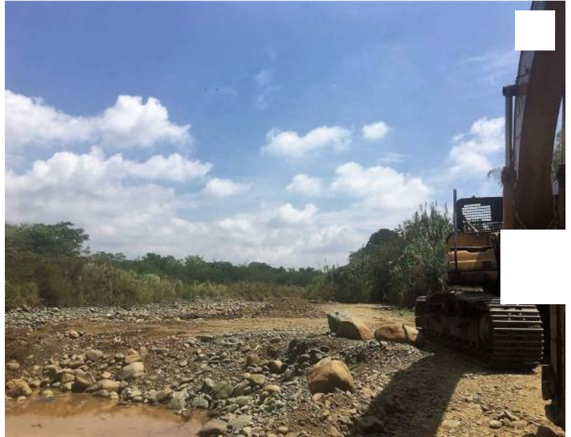
Los trabajos de explotación de materiales rocosos en el lecho del río Pance se adelantan a la altura del puente de la Carrera 125, cerca a la sede del Deportivo Cali. Cortesía para El País
