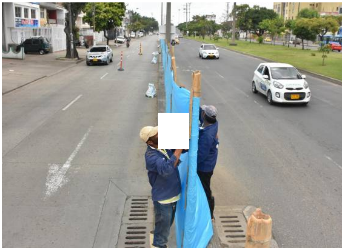
Cierres parciales en la Autopista Suroriental de Cali irán hasta diciembre Periodista: Andrea Otero / Cámara y edición: Camilo Rodríguez
