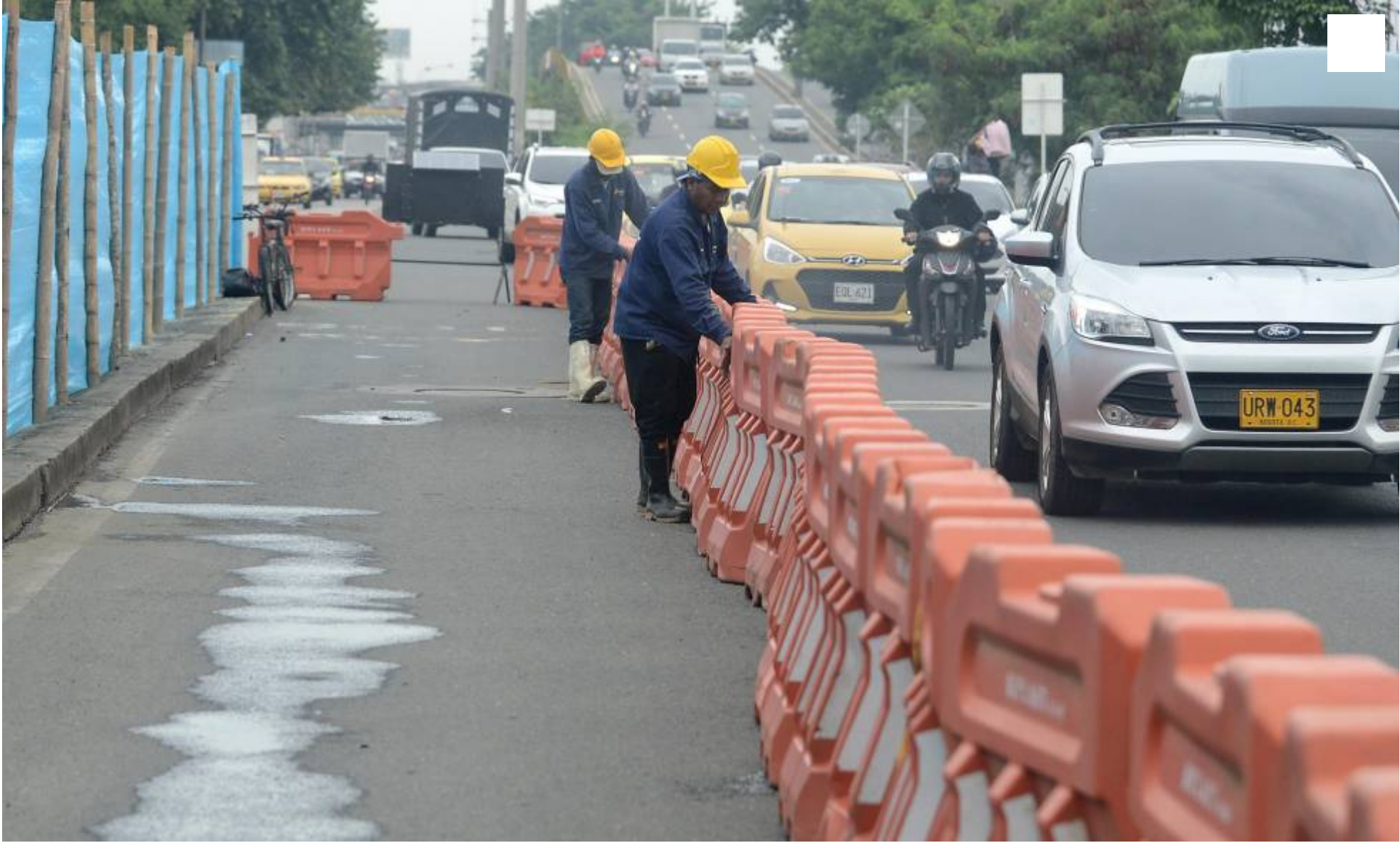
400 metros de tubería, serán intervenidos en la fase de limpieza que adelantan contratistas de Emcali. Inicialmente se han contratado a 13 personas que rotarán sus turnos entre 15 y 20 minutos bajo tierra. José L. Guzmán / El País
