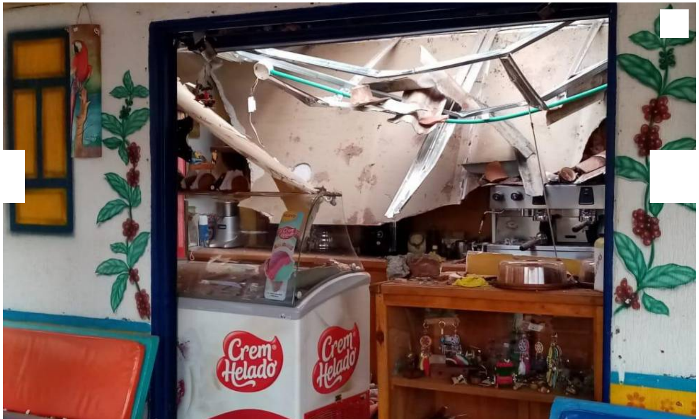
Cafetería en el municipio de Darién registró alrededor de 30 millones en pérdidas, tras el temblor. Tomado de redes sociales
