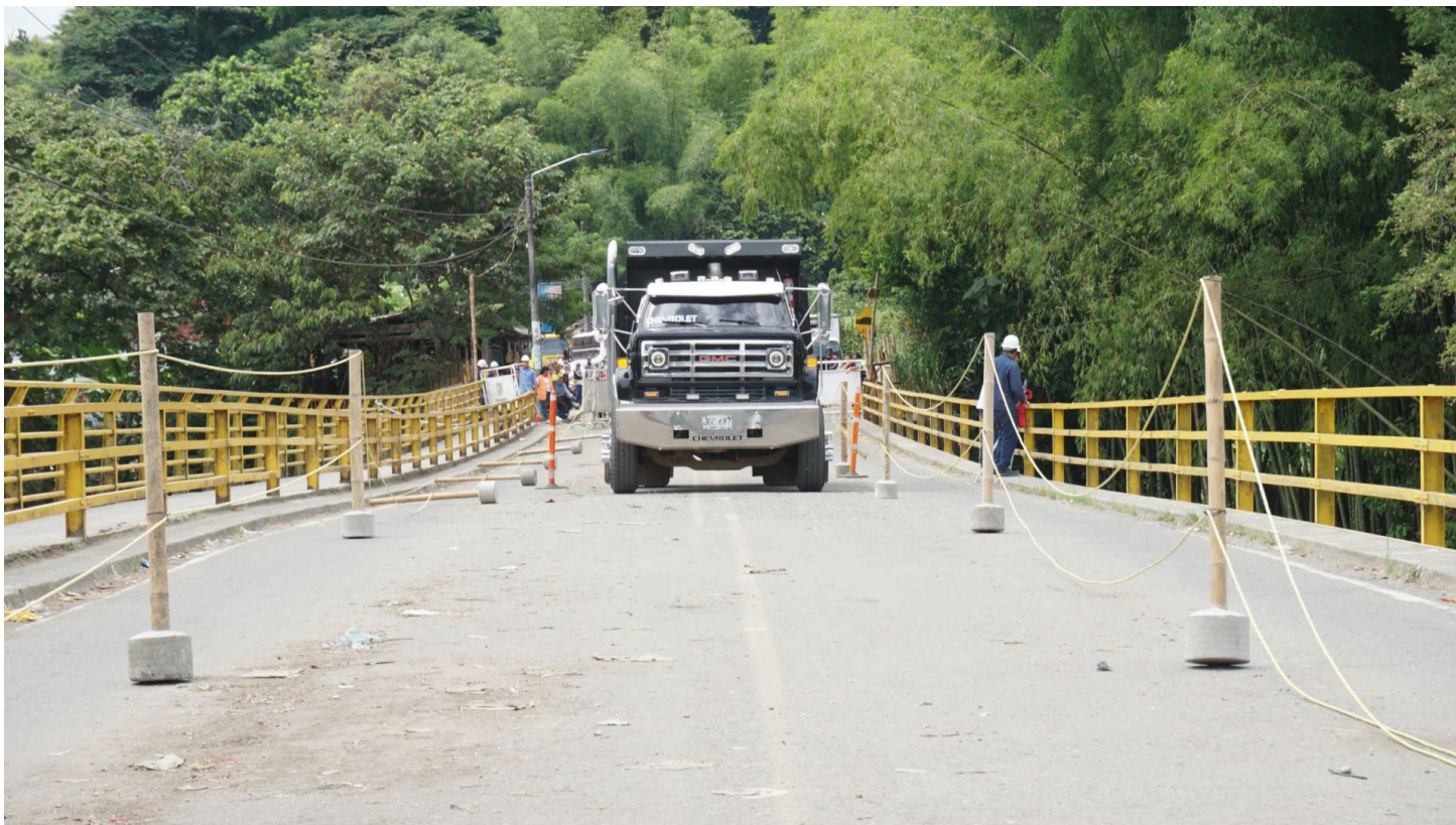
Momento en el que el contratista hace una prueba de carga con una volqueta en el puente Barragán. Foto: Cortesía Alcaldía de Caicedonia | Foto: Alcaldía de Caicedonia
