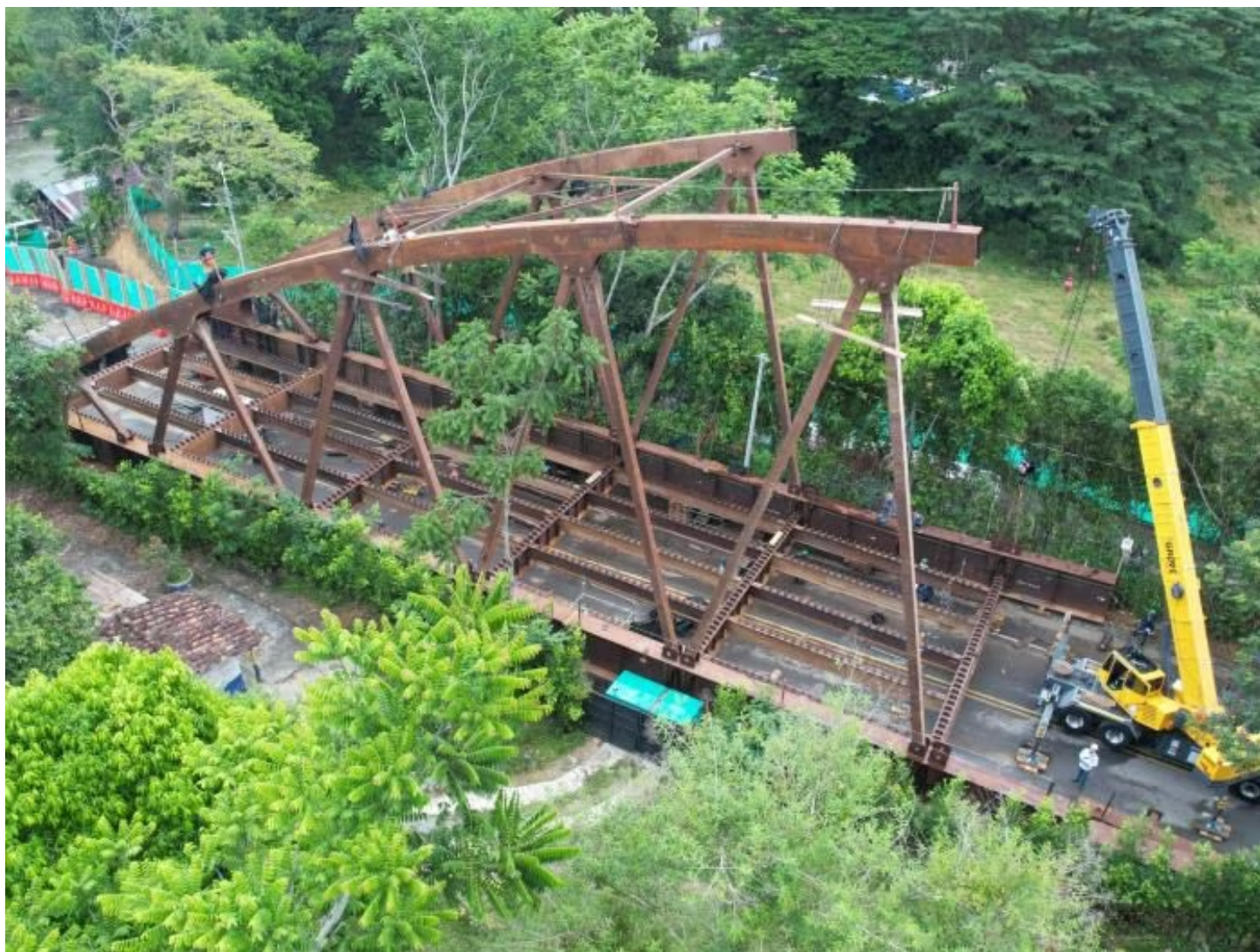
Así avanzan las obras en el Puente alambrado. | Foto: AUTOPISTAS DEL CAFÉ
