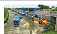
Metro Cali informa que la terminal del MÍO en Calipso tendrá a partir de este lunes trabajos de mantenimiento
