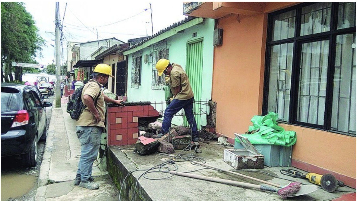
Trabajadores contratistas demuelen antejardines.
