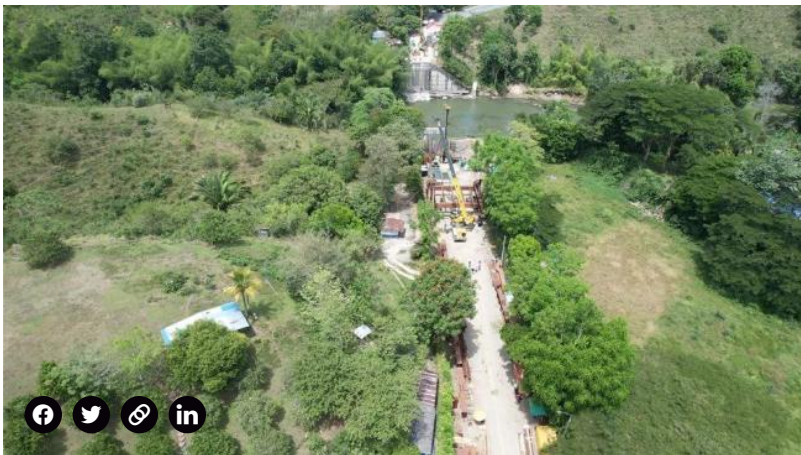
Obras del nuevo puente El Alambrado, que avanzan en un 42 por ciento.
