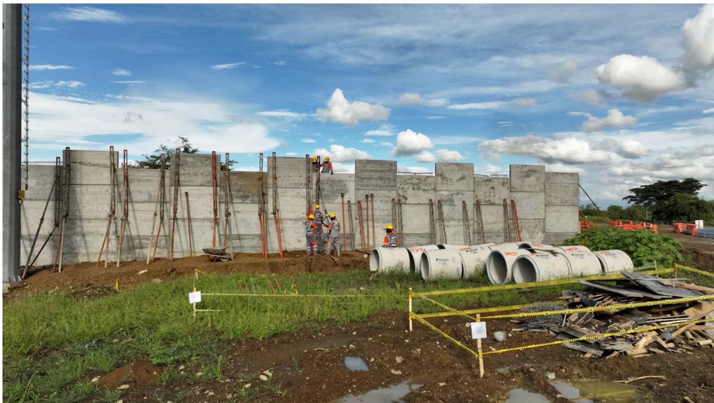
En algunos tramos de la construcción ya se adelanta la construcción de vigas y pilares para los puentes. | Foto: Concesionario Rutas del Valle.
