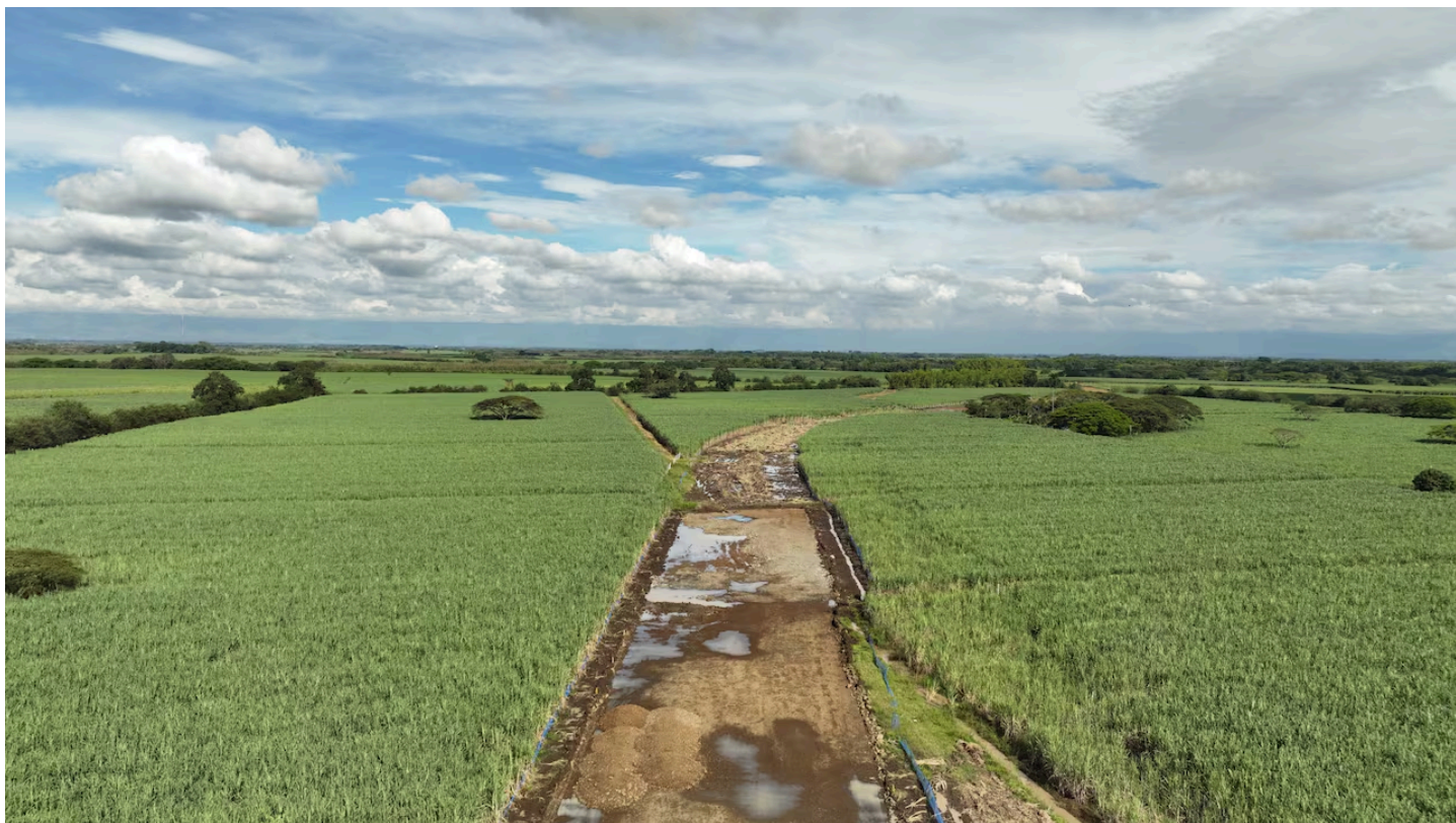
En algunas partes ya se ha iniciado con el despeje de algunos terrenos por los que pasará la vía. | Foto: Concesionario Rutas del Valle.
