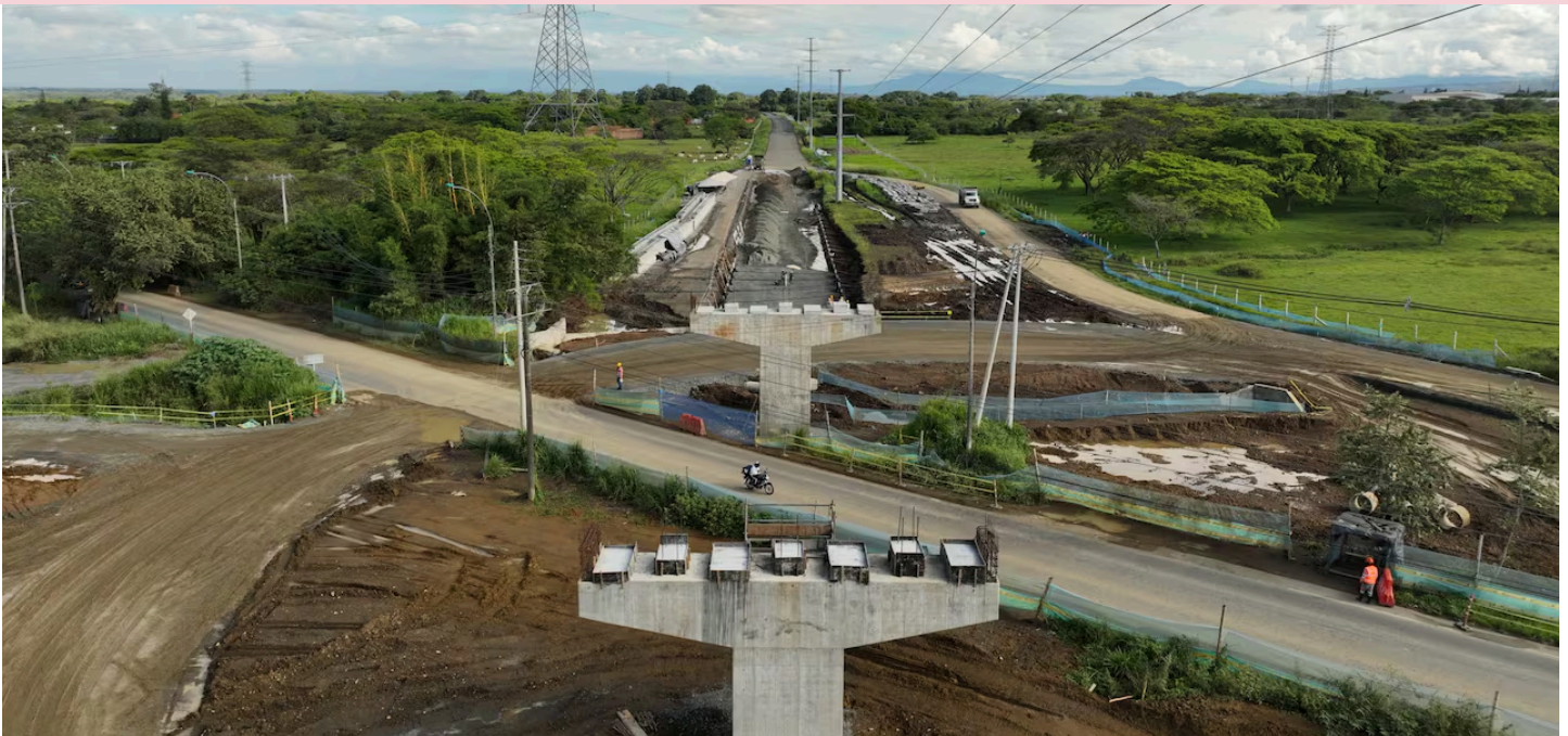
Varios sectores ya cuentan con la capa asfáltica. La obra en general cuenta con 15,8 kilómetros de extensión e inicia desde la Carrera 109 en Cali. | Foto: Concesionario Rutas del Valle.
