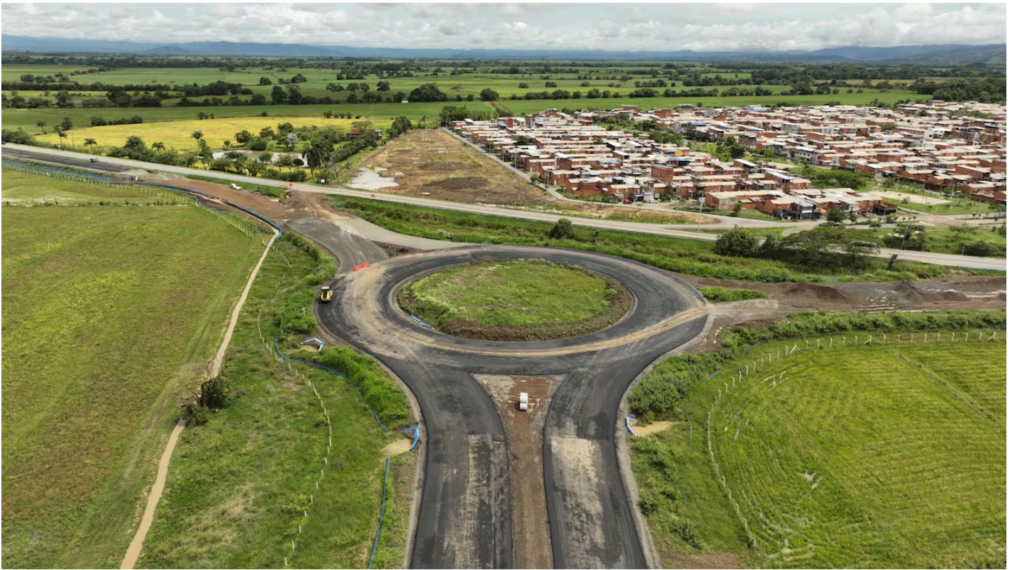
En la intersección entre la Avenida Ciudad de Cali y la vía a Puerto Tejada se realizará una rotonda para poder facilitar el acceso de los vehículos que buscan entrar y salir de la ciudad. Este frente de obra está en un 50 % y se han realizado labores asfálticas. | Foto: Concesionario Rutas del Valle
