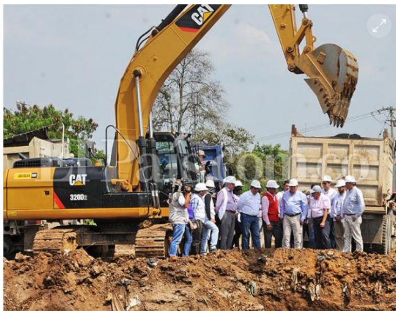
Las autoridades nacionales y locales realizaron ayer una visita a las obras de reforzamiento del jarillón del río Cauca, que se ejecutan en la Carrera 50 con Avenida Simón Bolívar. El País.
