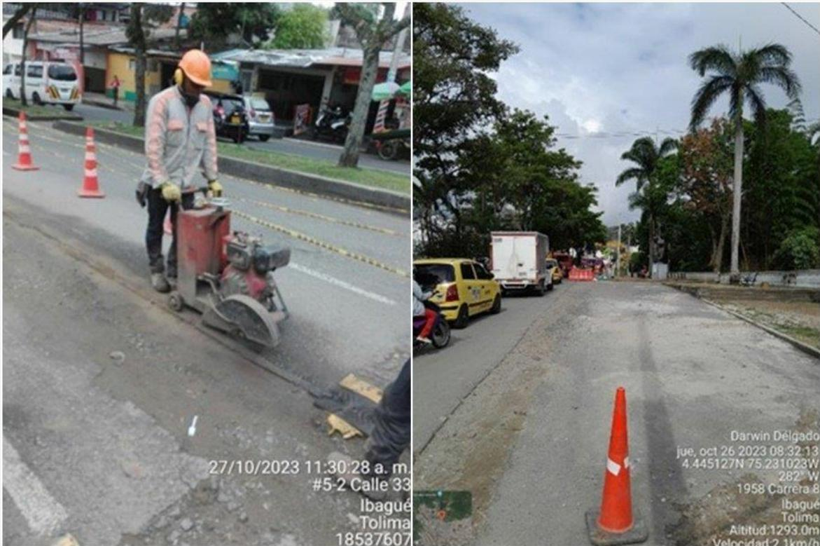
"Desde el 23 de octubre comenzamos labores en el sector y **actualmente tenemos personal capacitado realizando labores previas** que son indispensables para la reposición de asfalto, como corte de carpeta asfáltica uniforme, nivelación de zanjas con material correspondiente, cajeo con base asfáltica y compactación de la misma", respondió Celsia.
