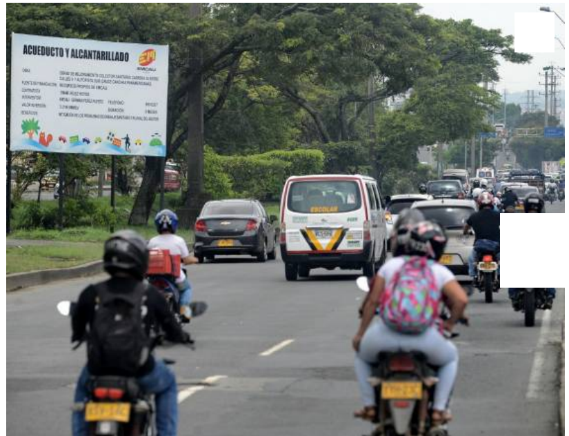
En el cruce entre la Carrera 29A y la Autopista Suroriental las autoridades de Tránsito instalarán un semáforo intermitente para controlar el flujo vehicular sobre la carretera. Emcali aseguró que se espera que las obras tomen alrededor de 80 días. José Luis Guzmán / El País
