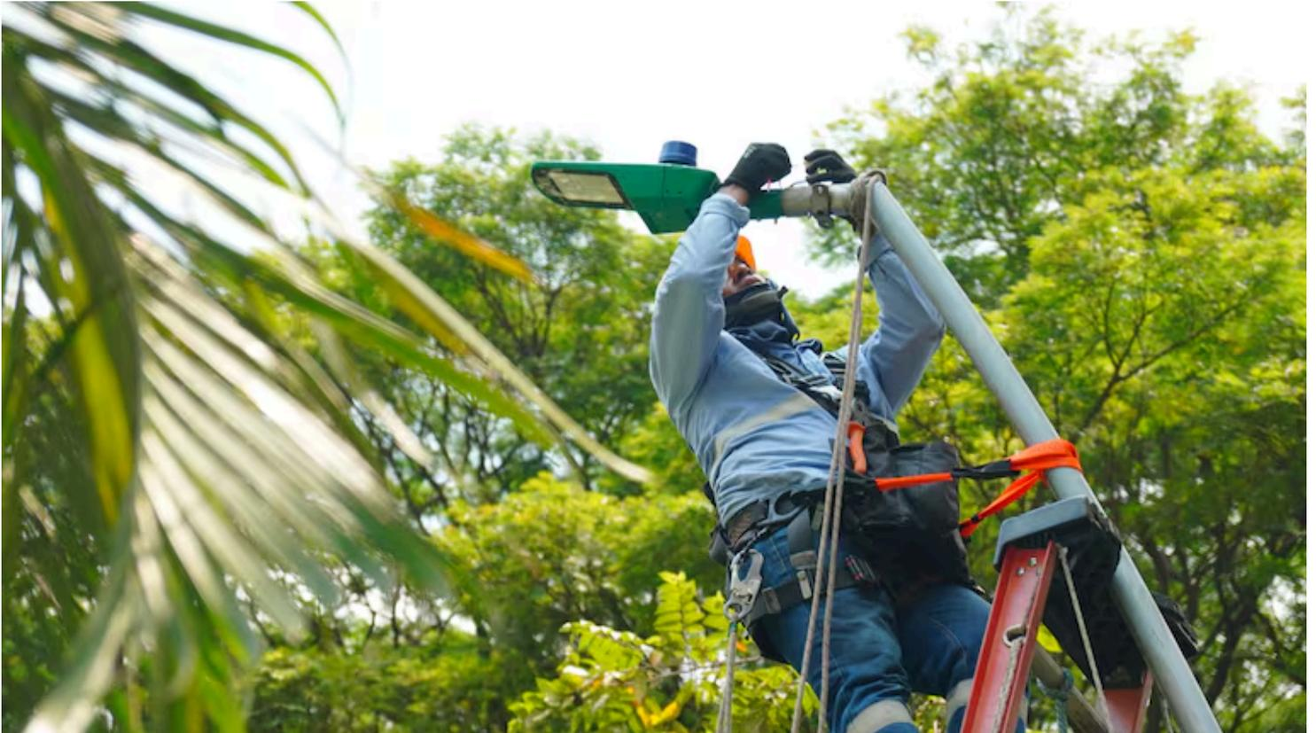
Las cuadrillas disponibles trabajan de forma simultánea cambiando las antiguas bombillas de sodio por luces LED. | Foto: EMCALI
