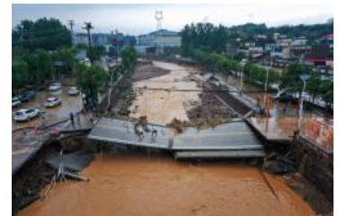
Emergencias por lluvias en China dejan al menos 33 muertos y 8 desaparecidos
