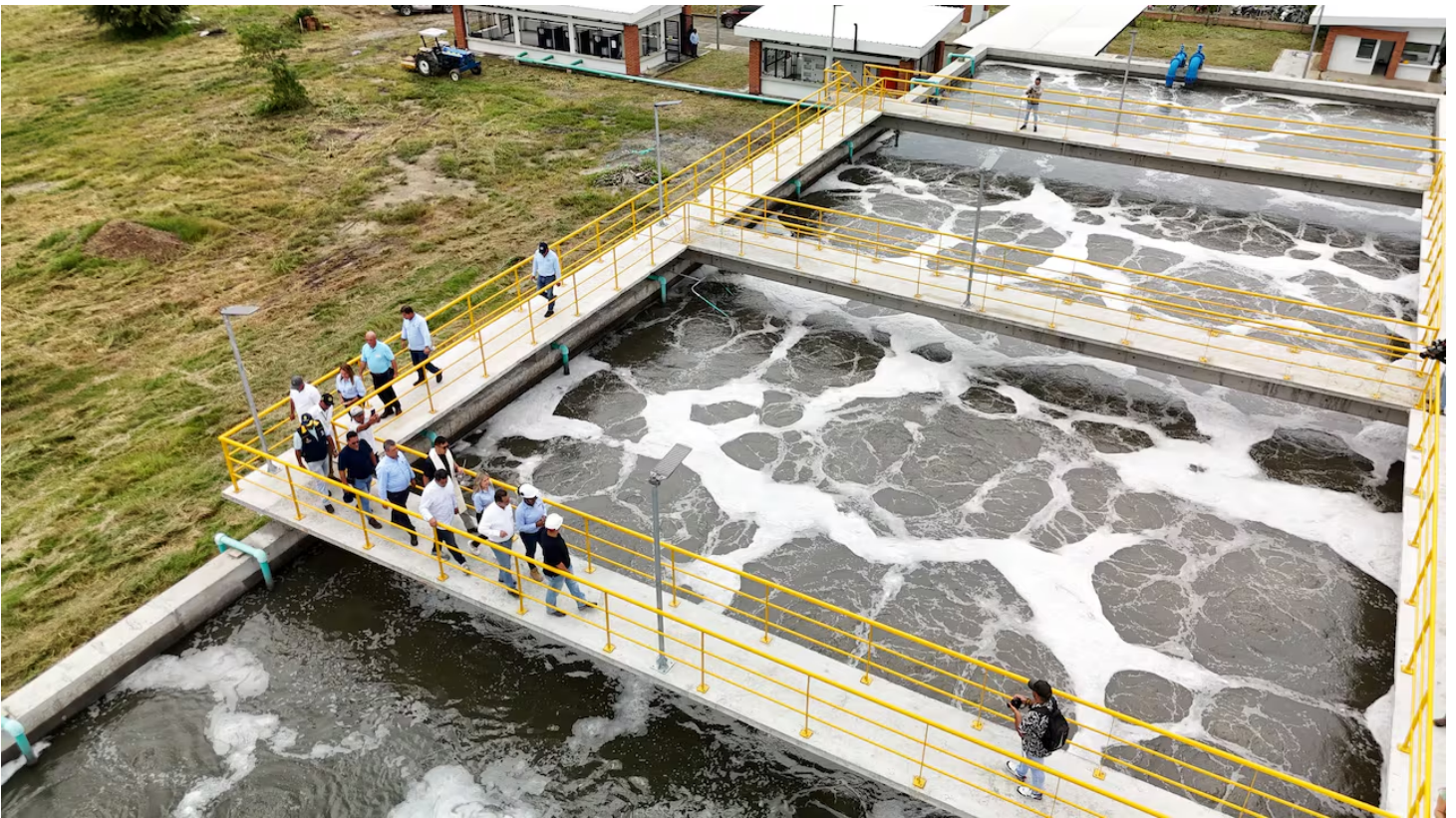
Esta obra hace parte de las 11 plantas que construye la CVC en el Valle. | Foto: Cortesía de la CVC
