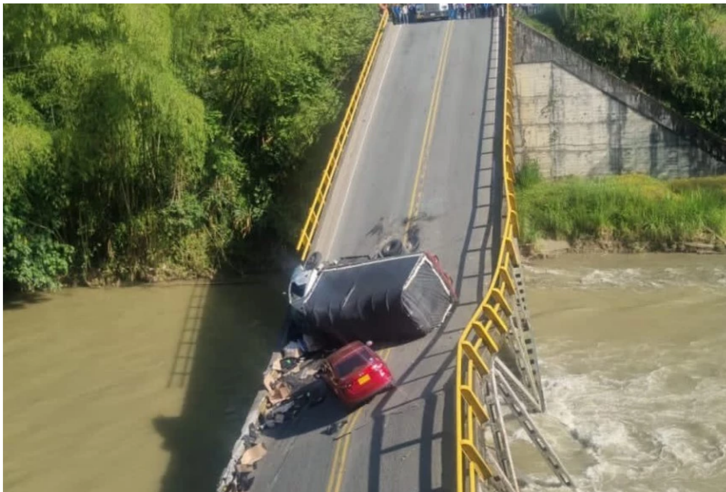
Puente El Alambrado
