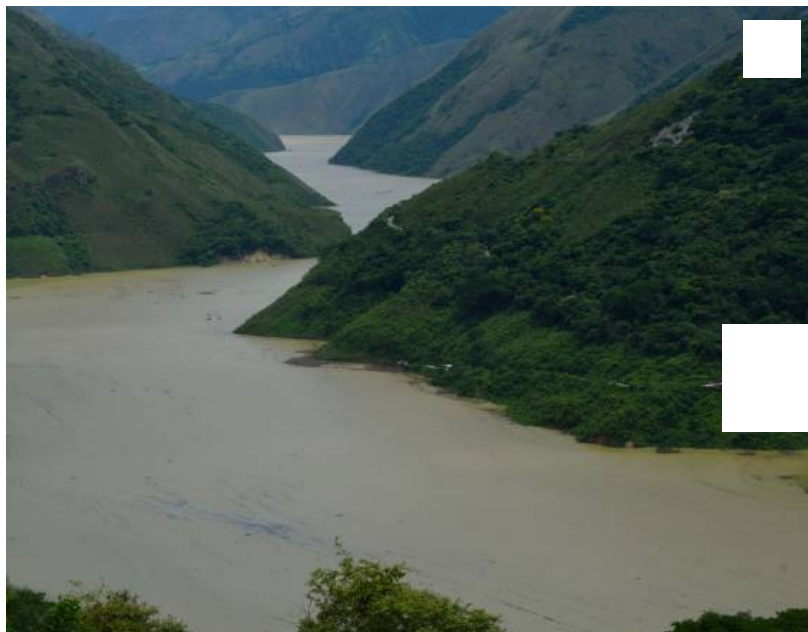
El proyecto de Hidroituango está ubicado sobre el río Cauca entre el municipio de Ituango y el corregimiento de Puerto Valdivia. Cortesía EPM
