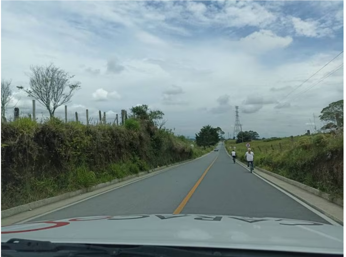
7.8 Kilómetros de vía asfaltada entre Circasia y Montenegro
