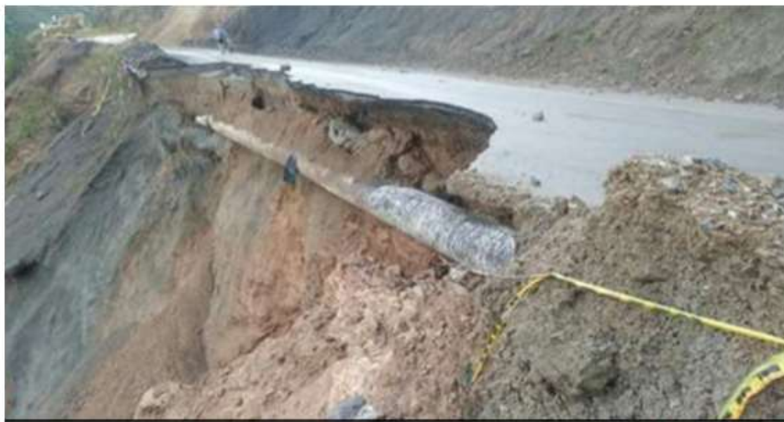
Falla geológica en la vía que une el municipio de Bolívar con el corregimiento Primavera. Foto de Acuavalle.
