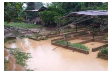
Desbordamiento del río Aguaclara en Palmira afectó a diez viviendas
