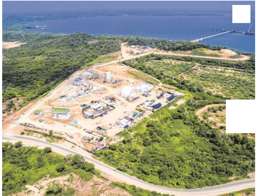
Infraestructura. Además de la planta regasificadora, que se ejecutará en el municipio de Buenaventura, se licitará un gasoducto de 110 kilómetros de 30 pulgadas de diámetro. También debe contarse con una estación de transferencia. Especial para El País
