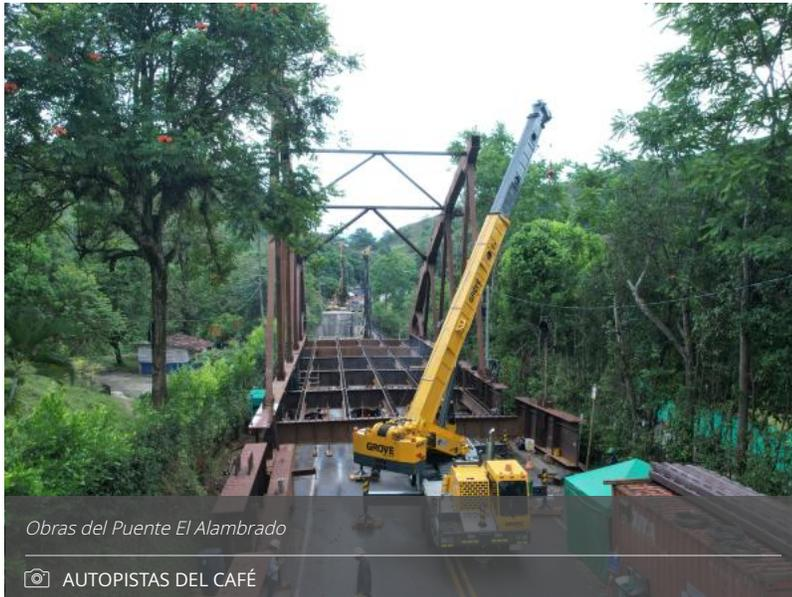
**Esta nueva estructura será de 102 metros de longitud, con dos arcos paralelos laterales con altura de 17 metros y un peso de 580 toneladas.**
