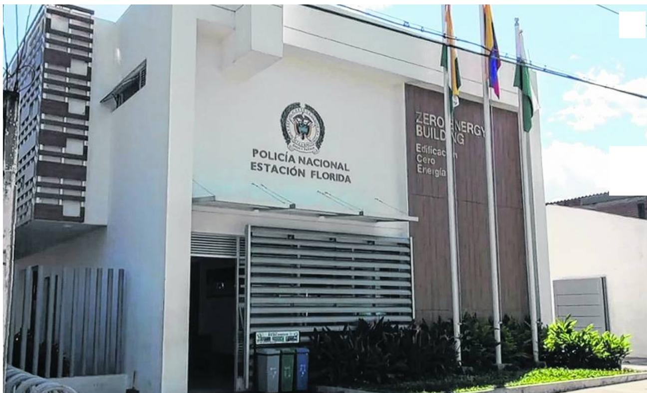
La protección de las fachadas, juega un papel importante, evita que estén expuestas a radiación solar y el sobrecalentamiento. También, cuenta con aislamiento térmico de muros para evitar sobrecalentamiento interior.
