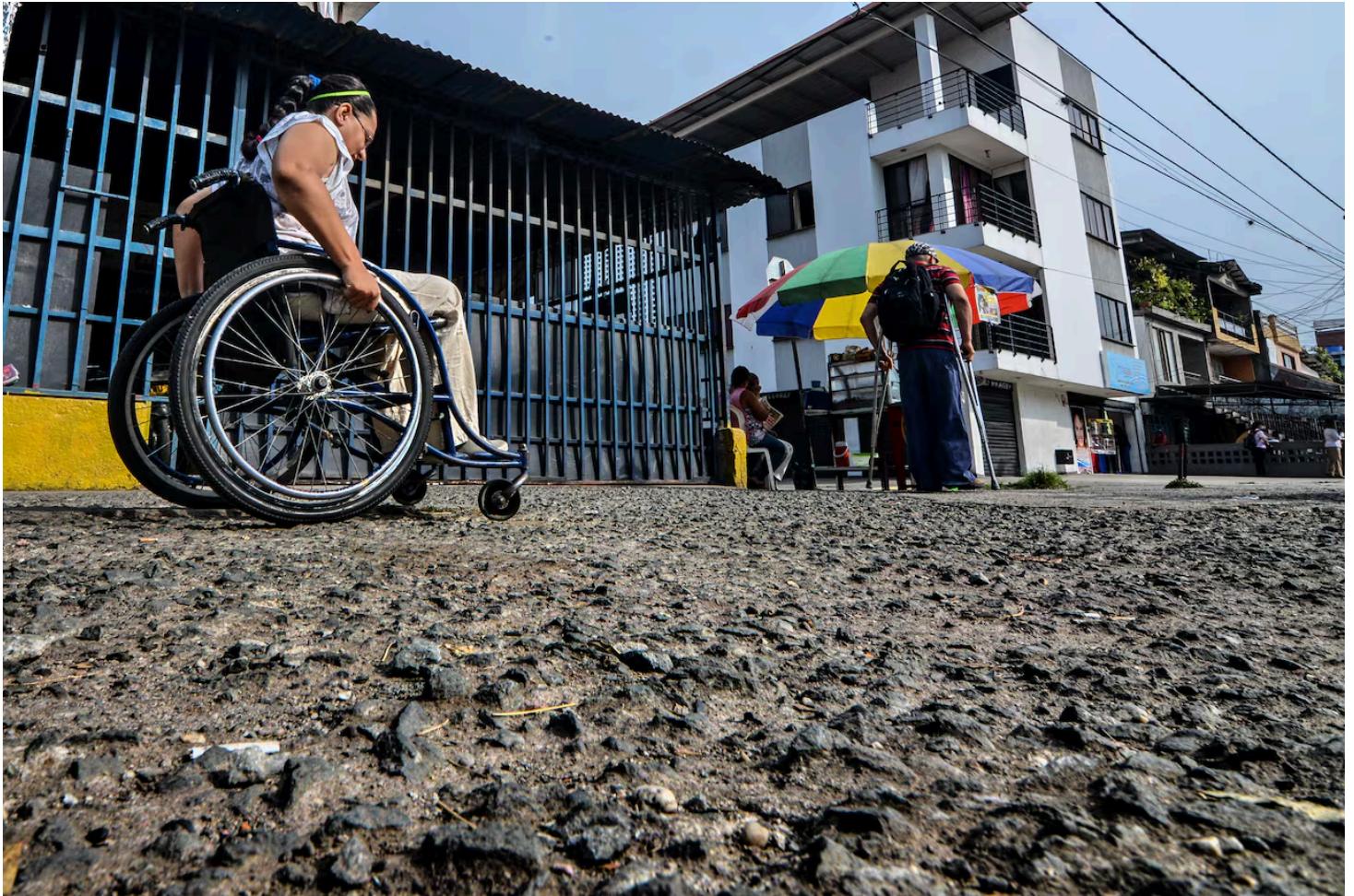
Los andenes en varios puntos de Cali no cuentan con las especificaciones técnicas para garantizar la movilidad de las personas con silla de ruedas. | Foto: Jorge Orozco
