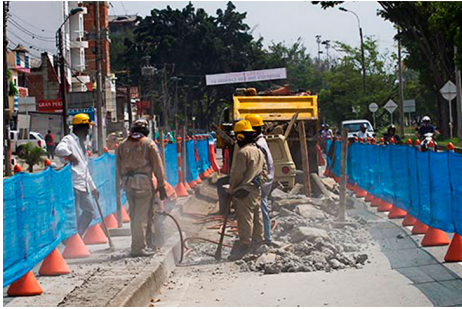
Iniciaron cierres en la Autopista Sur por obras de Emcali
