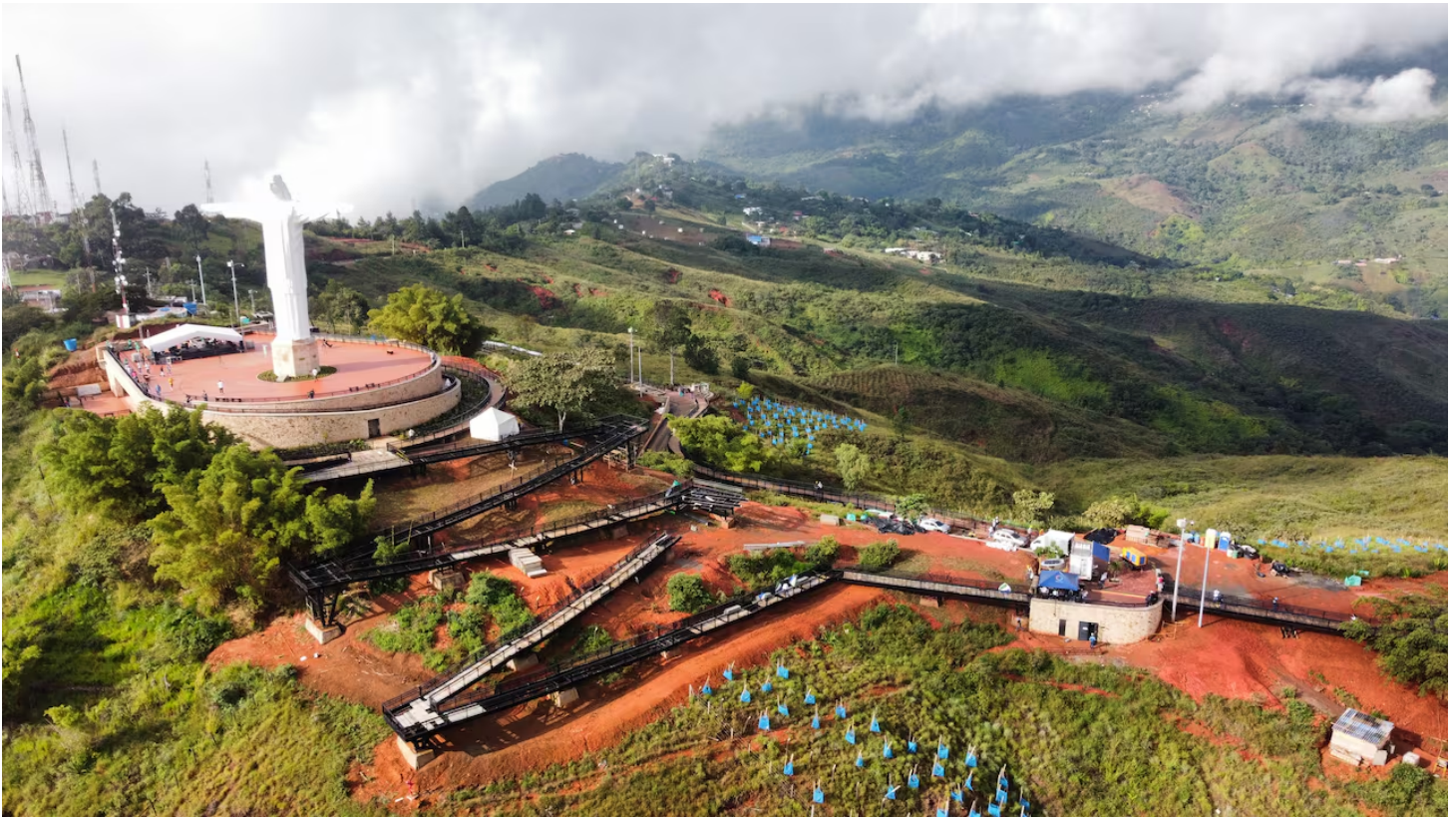
En la imagen se aprecian las obras que se adelantan en el sendero de Cristo Rey y su cercanía con el lote de Hamacas. | Foto: Raul Palacios
