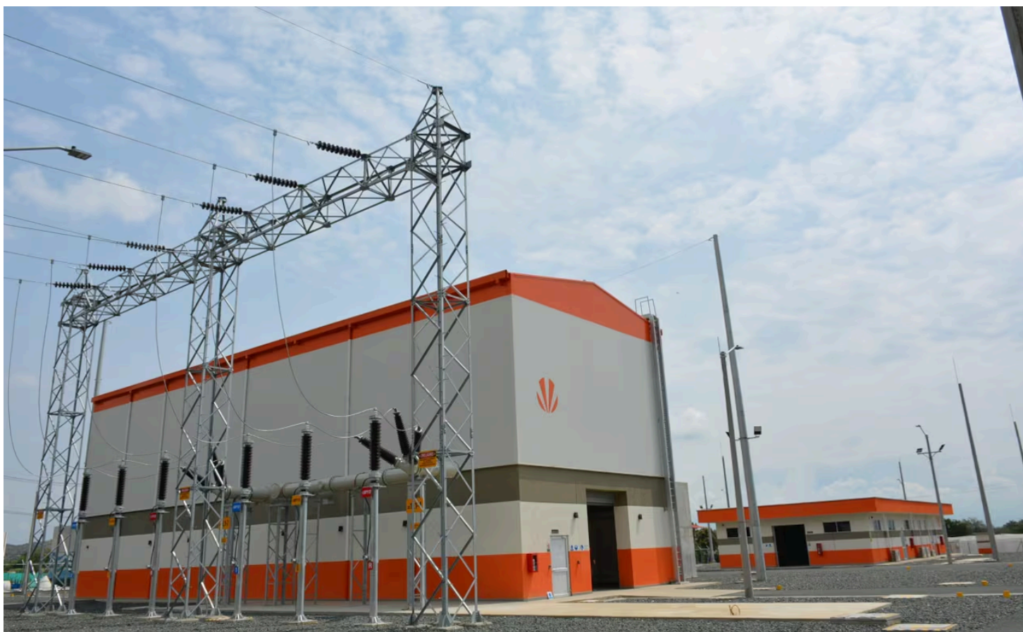
Celsia ha emprendido un plan para sostener la infraestructura de la red eléctrica del departamento en óptimas condiciones. | Foto: Foto: Celsia
