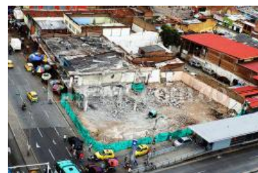
Avanza la demolición de predios en Ciudad Paraíso
