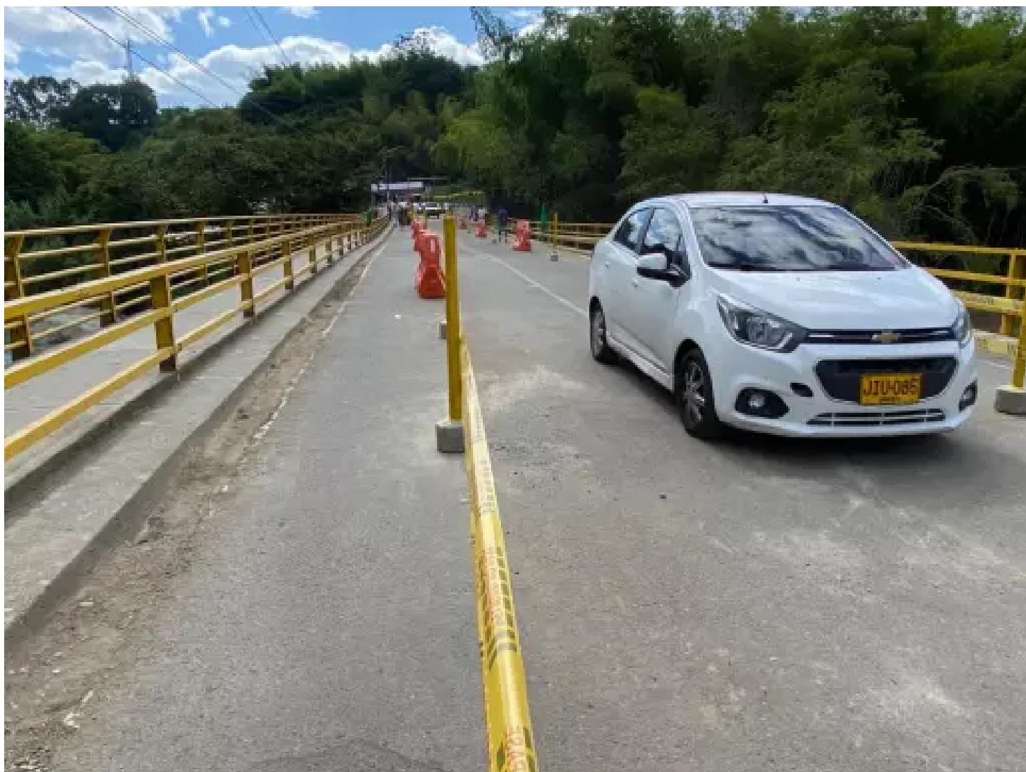
Puente de Barragán Este: Gobernación del Valle
