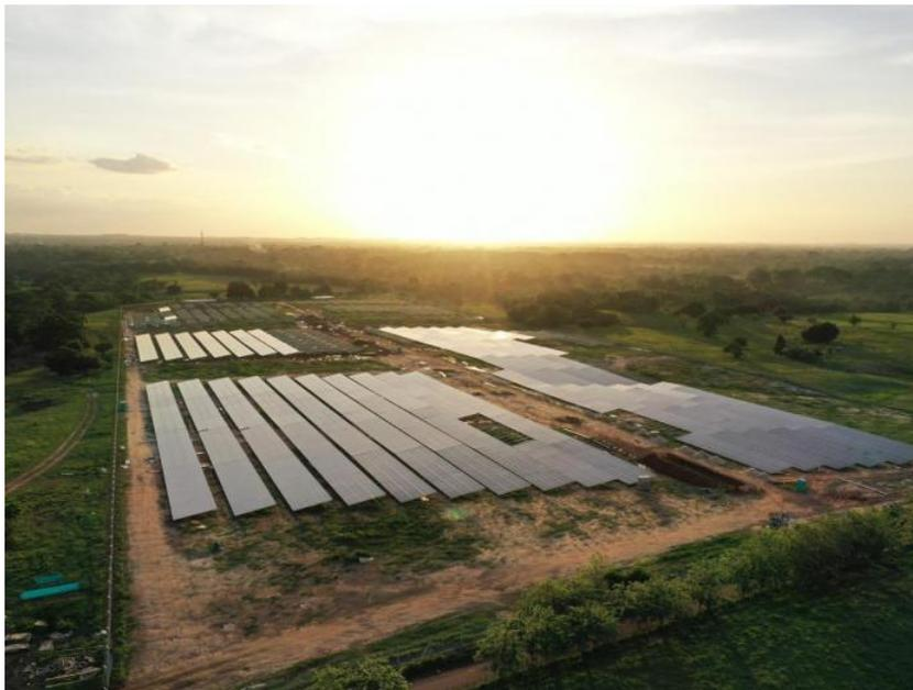
La planta "Pétalo de Córdoba I", ubicada en la vereda de Aguas Blancas, posee una capacidad instalada de 12 MWac capaz de generar 17333 MWh/año
