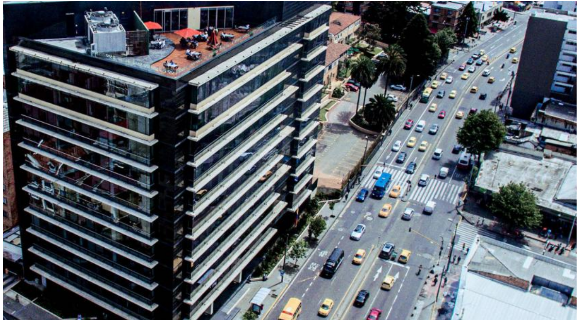
Instalaciones de la JEP en Bogotá.
