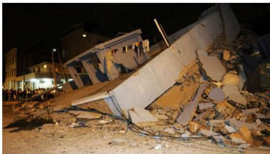
Sismo en el Ecuador. Estructura colapsada.
