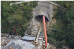
GOBIERNO APRUEBA $133.000 MILLONES PARA TERMINACI N DE OBRAS DEL T NEL DE LA L NEA
