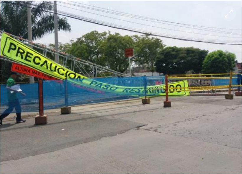
La estructura había sido ubicada en el puente de la Calle 21 con Avenida 2N por la realización de obras en el sector. Cortesía para Elpais.com.co
