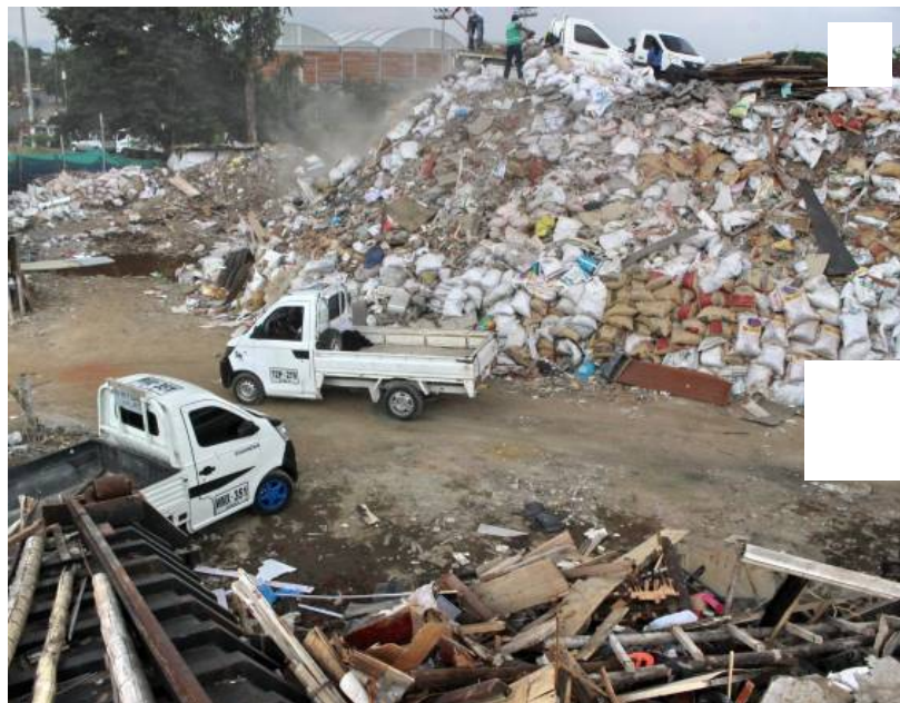
La escombrera de la Carrera 50 está saturada porque el proceso para la evacuación está en fase de contratación. Acodal ha advertido que la disposición inadecuada afecta fuentes de agua y causa problemas de movilidad, inseguridad y salud. Bernardo Peña / El País
