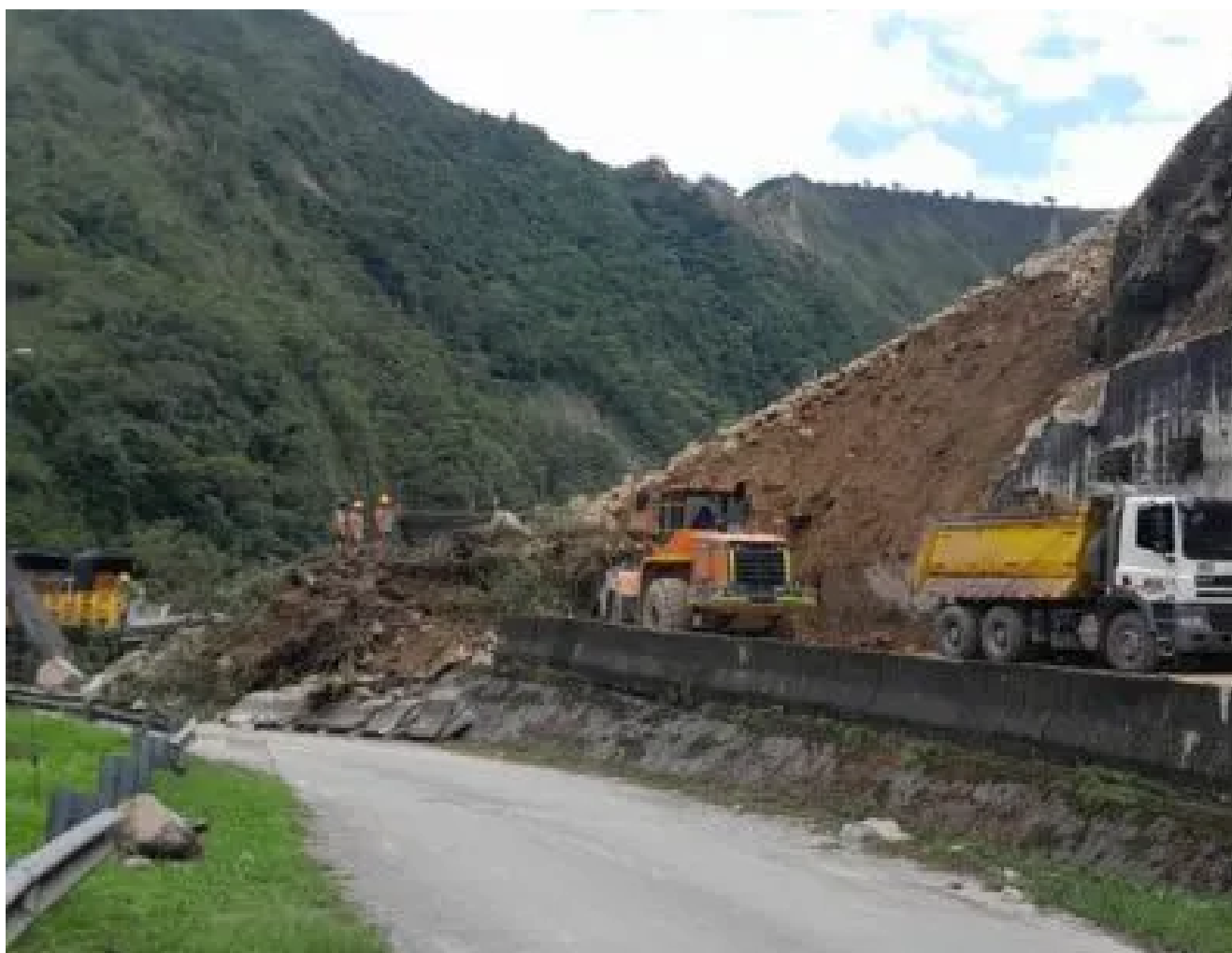
Avanzan las labores de remoción de material en la vía Bogotá – Villavicencio. Foto: Ministerio de Transporte.
