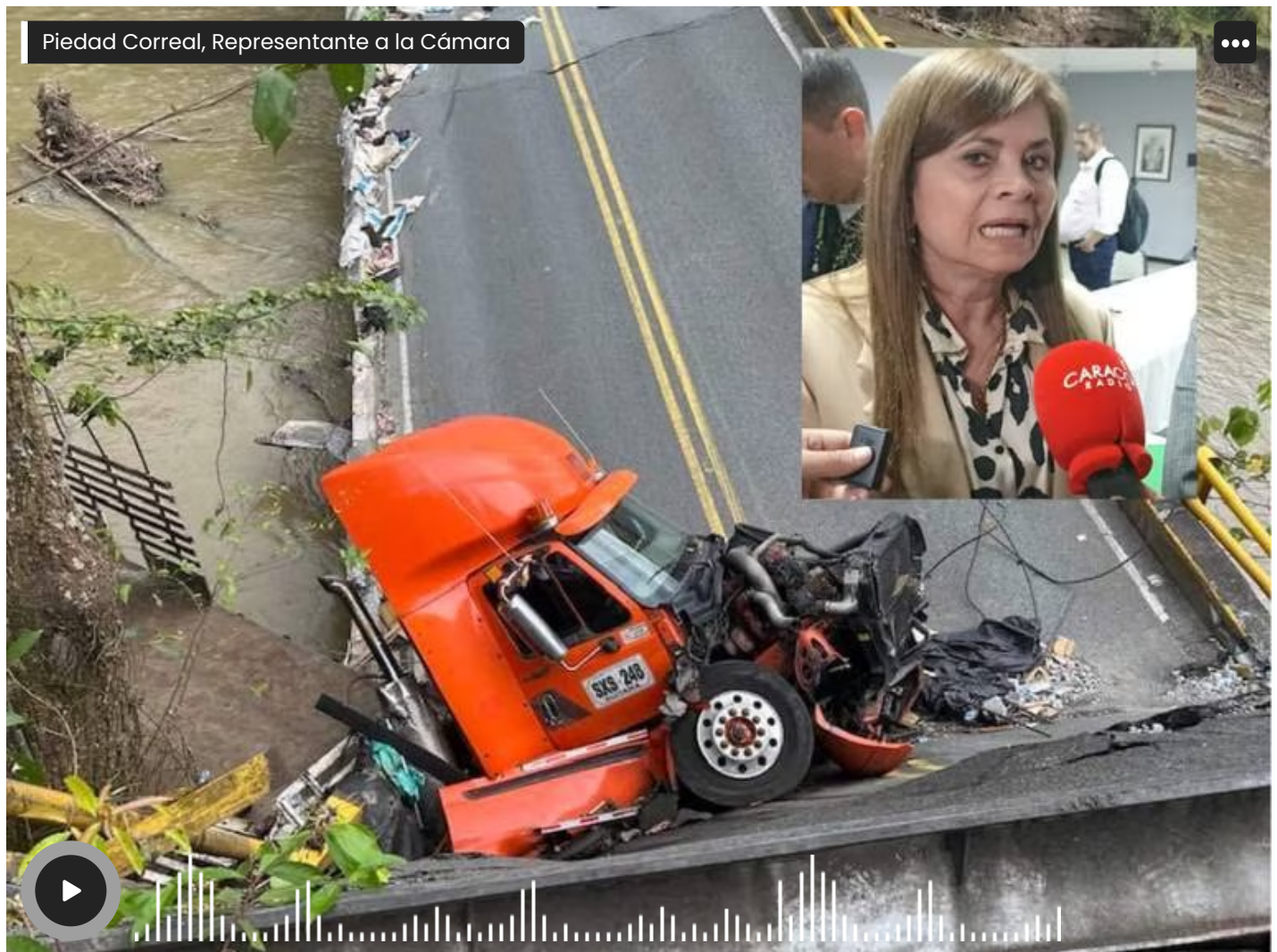
Tracto camión está todavía en el colapsado puente El Alambrado
