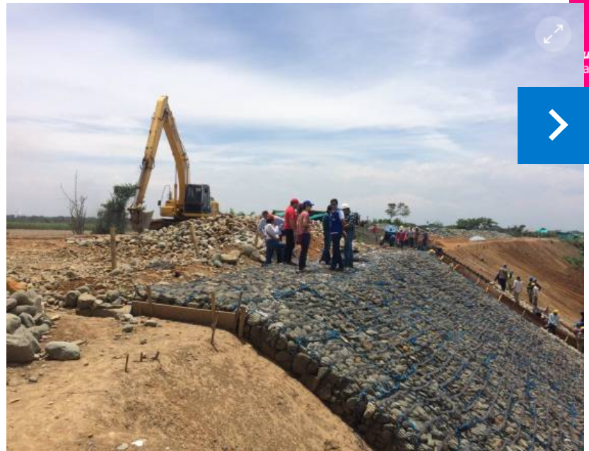
Con esta obra, la CVC busca proteger la integridad del dique contra inundaciones del río Cauca. Especial para El País
