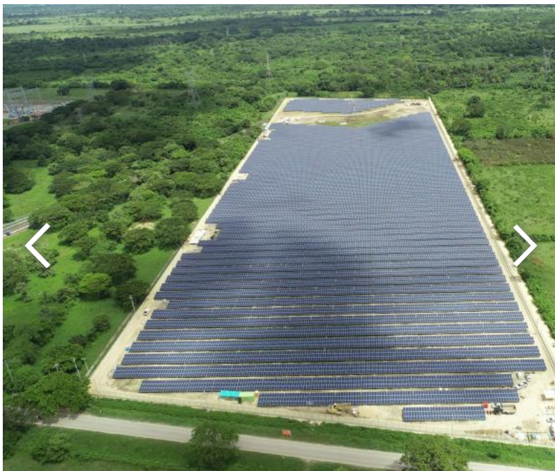
Parque 'Celsia Solar Bolívar', ubicado en el departamento de Bolívar. Con una una cap 8,06 MW.
