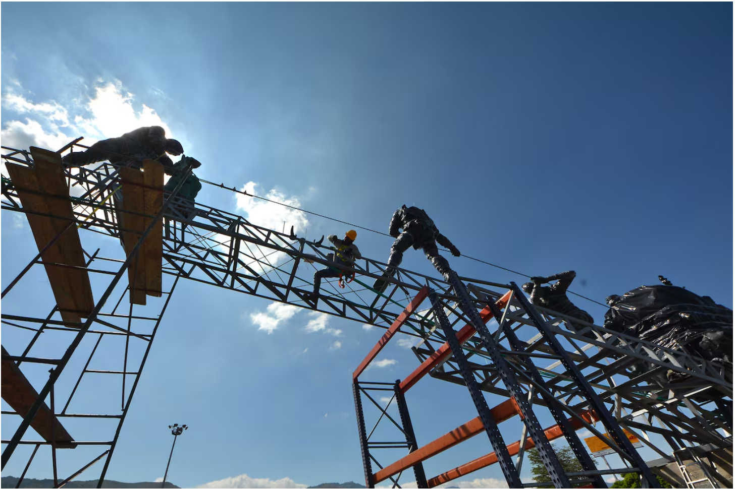
Los trabajos de restauración presentan un avance del 80 %. | Foto: Jorge Orozco
