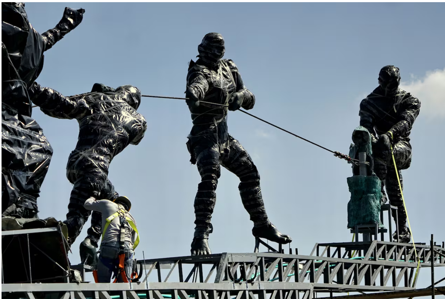
Las condiciones climáticas y el deterioro condujeron al debilitamiento y posterior fractura del monumento el 27 de abril del 2023. | Foto: Jorge Orozco
