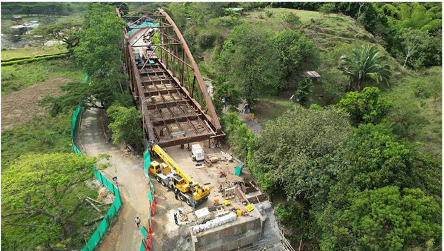
La estructura metálica del nuevo puente va en un 50 %, se han ensamblado 7 de las 14 secciones que componen el trayecto.
