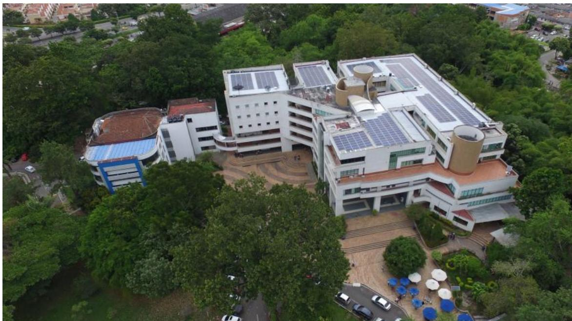
Así se ve el Edificio Santander con los 564 módulos solares instalados en el techo.
