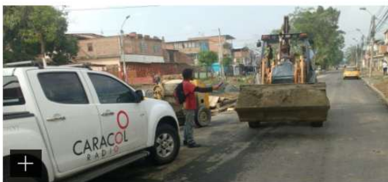
Obras de pavimentación en la Calle 42 de Calli / Foto: Caracol Radio/
