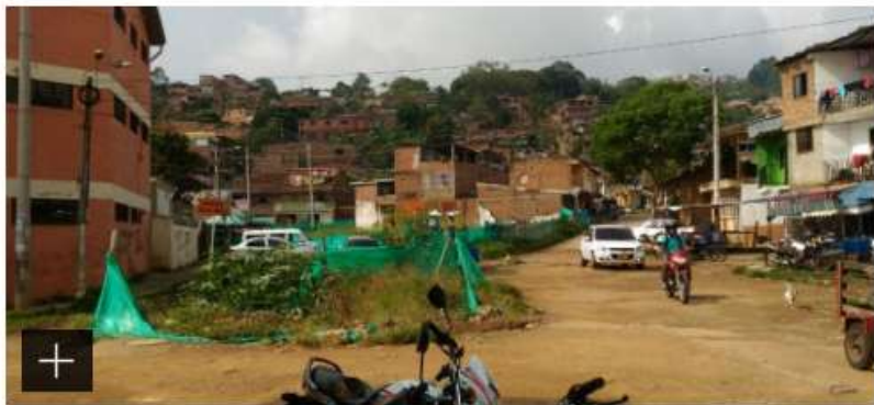
Atrasos en obras del sur de Cali / Foto: Caracol Radio/
