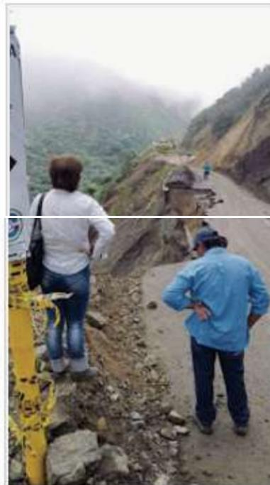
“Este es un daño diferente en la tubería de 28 pulgadas, producto de una desestabilización del terreno; sobre esa zona hay una falla geológica bastante compleja, lo que afectó la banca de la vía, que por cierto desapareció en ese sitio, y obviamente desestabilizó la tubería, el derrumbe lo que hizo fue desempalmarla en uno de los puntos”, explicó Guillermo Harvey Rodríguez, Gerente de Acuavalle.
