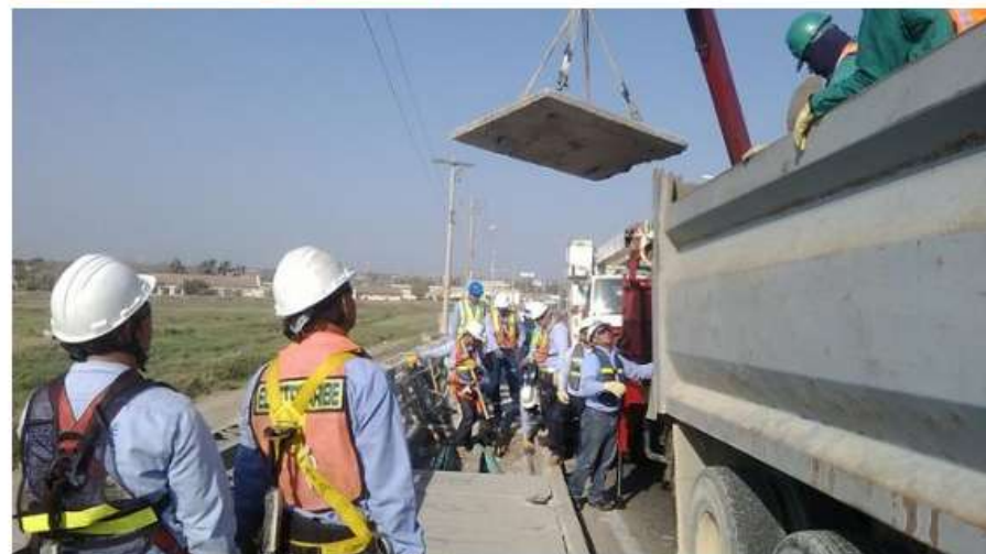
Trabajos de Electricaribe - Foto Colprensa - Juan Manuel Cantillo
